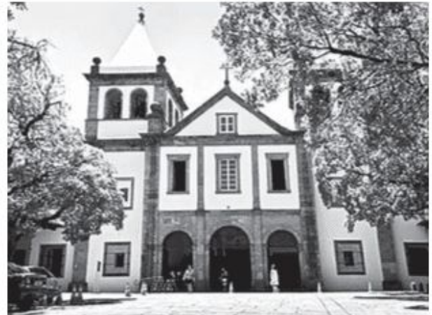
Mosteiro de São Bento (RJ)
